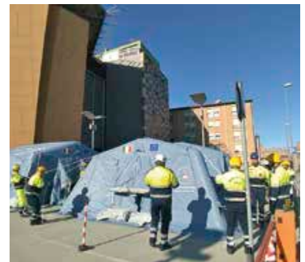
Montaggio tende pneumatiche presso l'Ospedale
